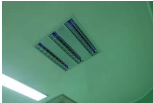
Gambar 4 Lampu Ultraviolet Pada Ruang Operasi
